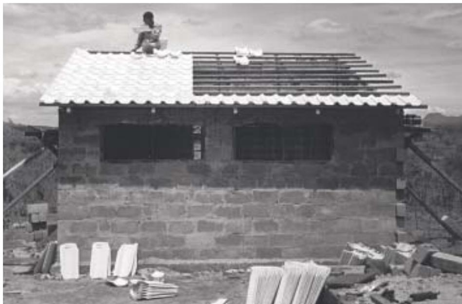
*Un techo de tejas necesita una estructura fuerte. Las tejas pesan más que las láminas de metal. El techo tiene que estar bien construido con medidas precisas y travesaños nivelados.*
