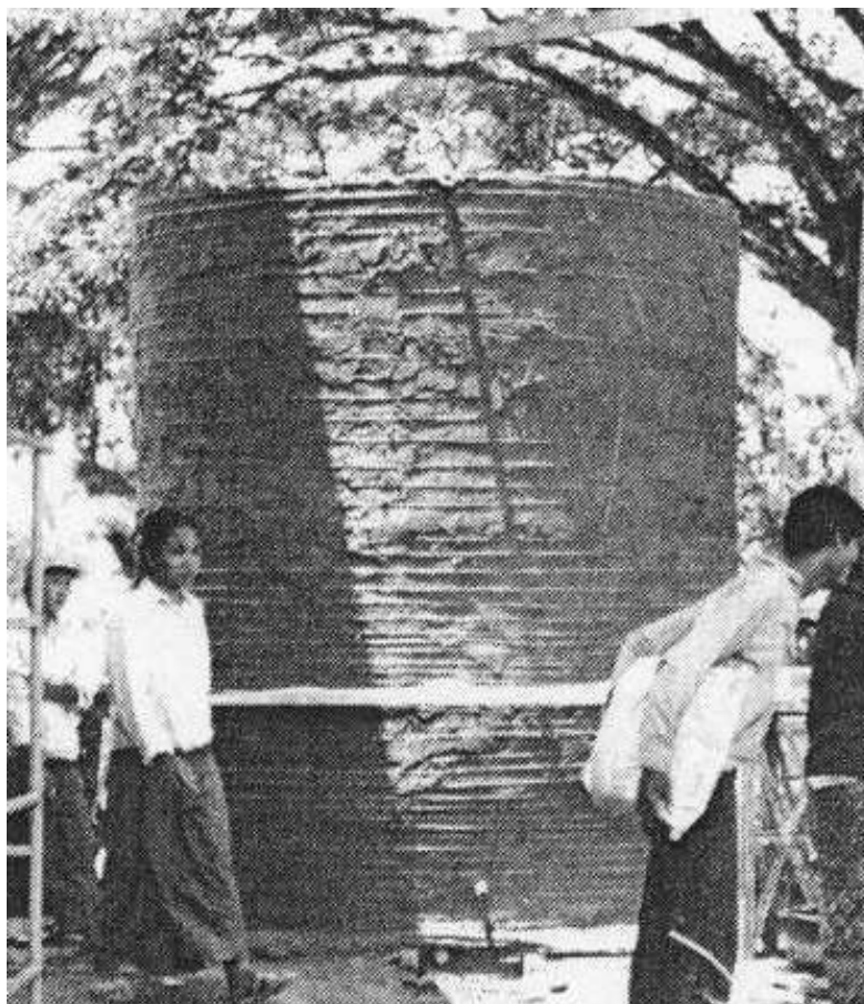
Figura 4. Tanque de Almacenamiento
